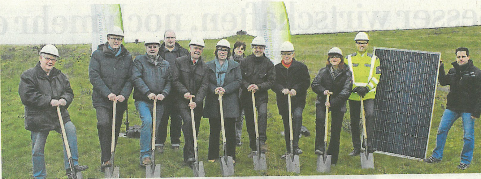
Der Spatenstich ist erfolgt, nun kann der größte Solarpark des Main-Kinzig-Kreises gebaut werden.
